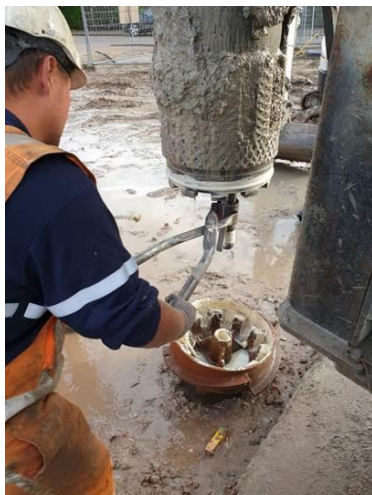
Afb. 7: Groutlans richten met een zelf ontworpen en geproduceerde tang.
