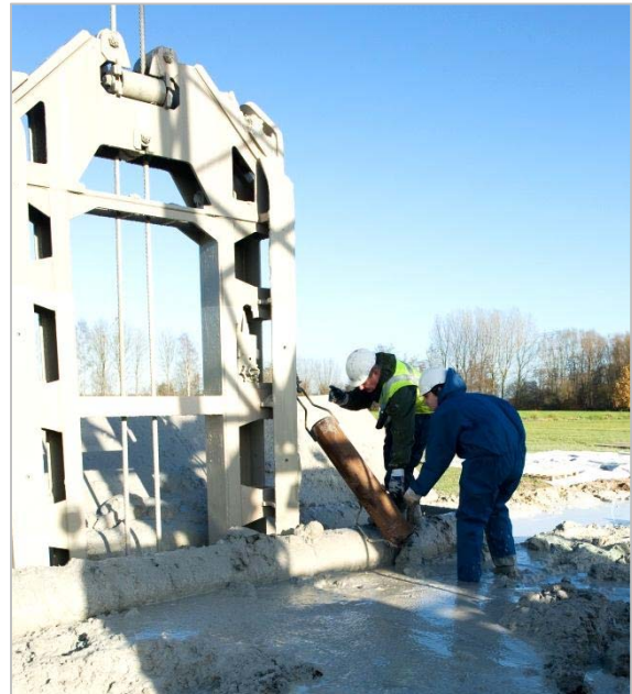
Bevestigen monsterbus cement-bentonietwand
