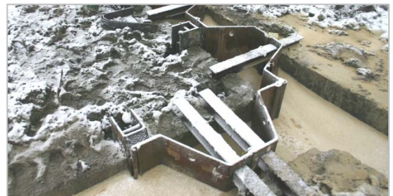
Cement-bentonietwand met damwand
