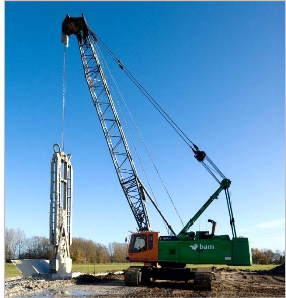
Graven cement-bentonietwand, 's-Gravenmoer
