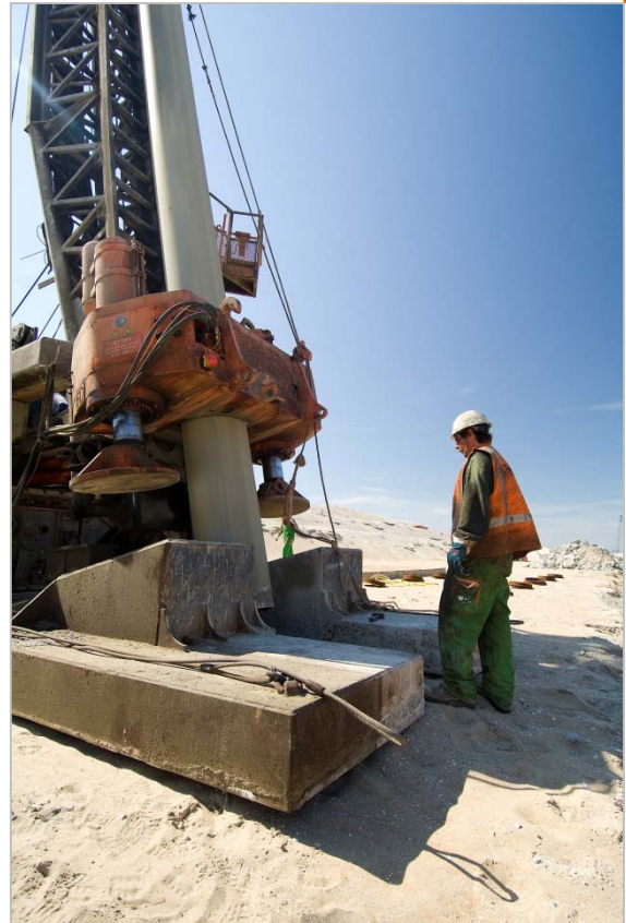
'Pile extractor', Maasvlakte 2
