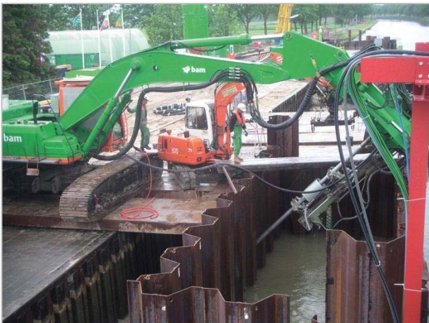
Groutankers sluis 10 Zuid-Willemsvaart
