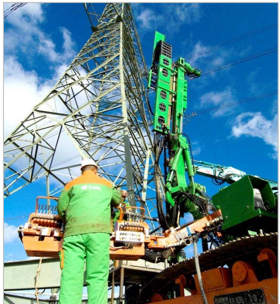
Verankering hoogspanningsmasten Markermeer
