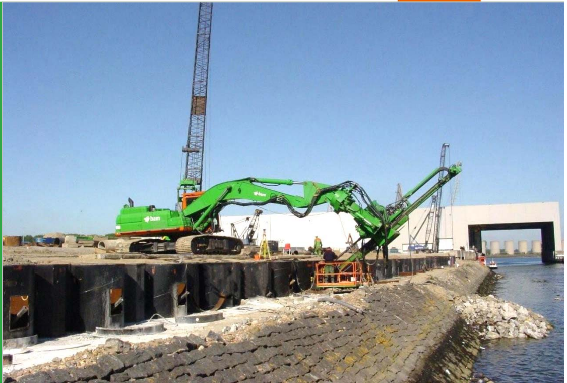
Boren groutankers kade Gevelco
