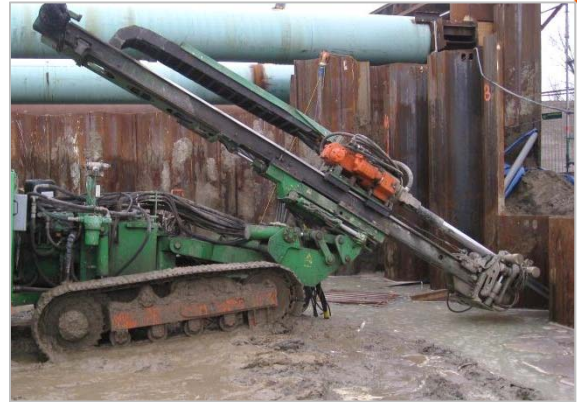
Aanbrengen van strengankers vanuit een deels ontgraven bouwkuip
