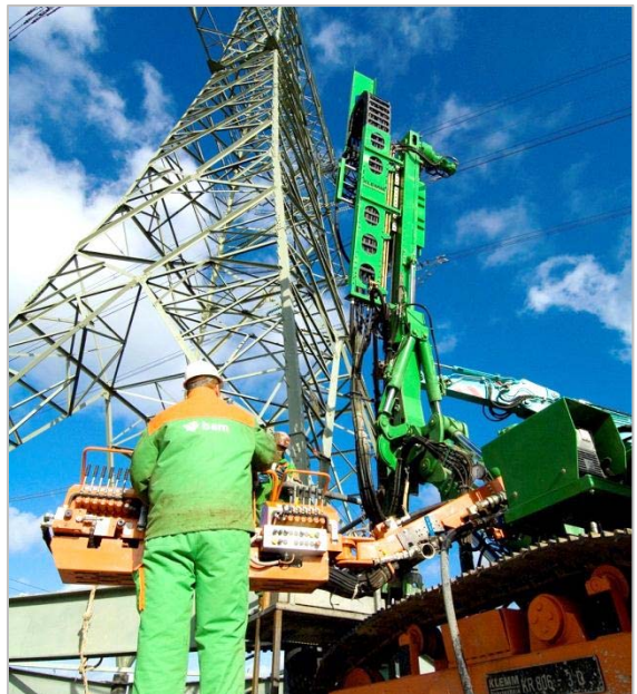
Verankering hoogspanningsmasten Markermeer
