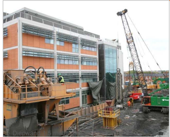
Diepwand 1,2 meter, Maasvlakte 2
