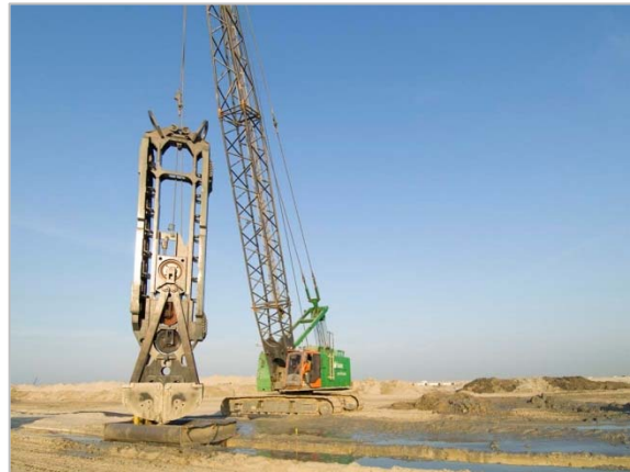
Diepwand 1,2 meter, Maasvlakte 2
