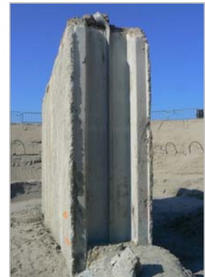
Detail diepwandvoeg, Maasvlakte 2
