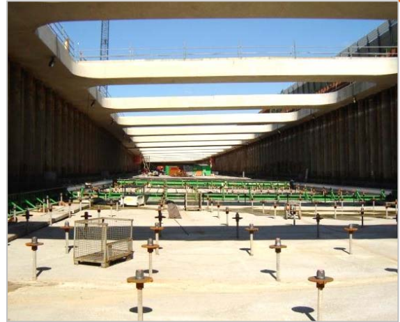
Aanbrengen Gewipalen vanaf traverse
