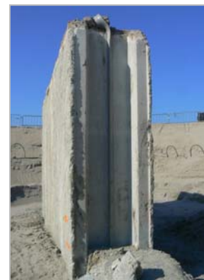
Detail diepwandvoeg, Maasvlakte 2
