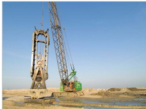
Diepwand 1,2 meter, Maasvlakte 2
