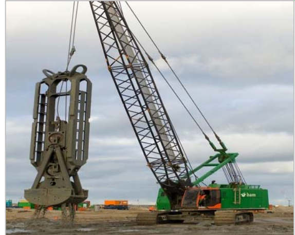
Graven diepwand, Maasvlakte 2
