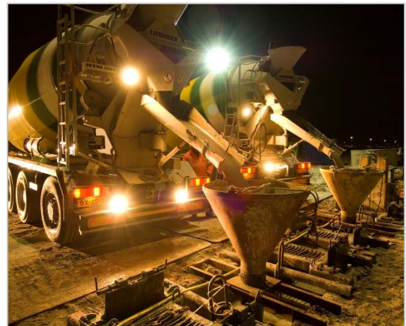
Storten beton, Maasvlakte 2
