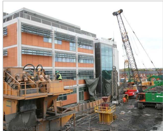
Diepwand 1,2 meter, Maasvlakte 2
