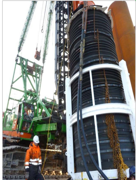
Heien combiwand met behulp van een geluidsbalg, Eemshaven
