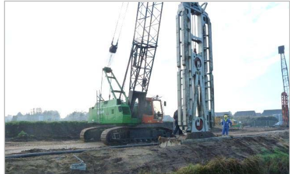
Detail graven cement-bentonietwand, 's-Gravenmoer
