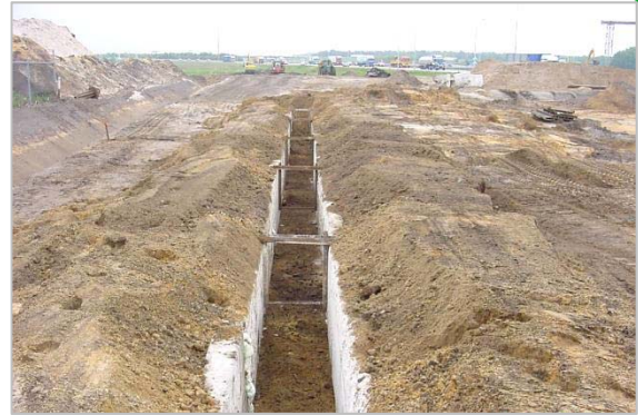
Geleidebalken cement-bentonietwand
