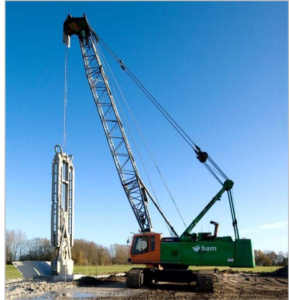
Graven cement-bentonietwand, 's-Gravenmoer
