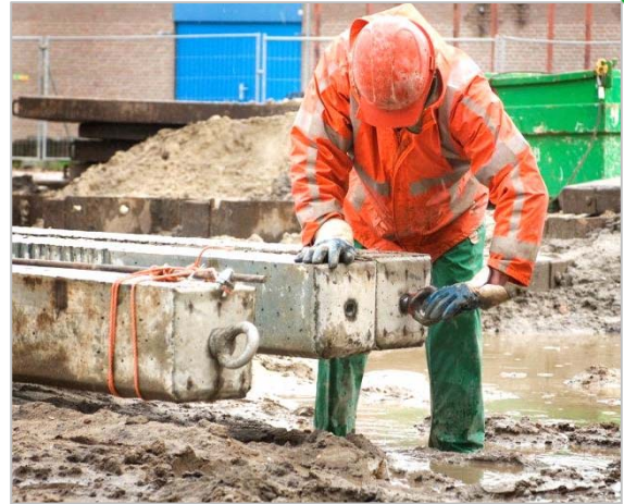
Afhangen prefab kern in boorbuis
