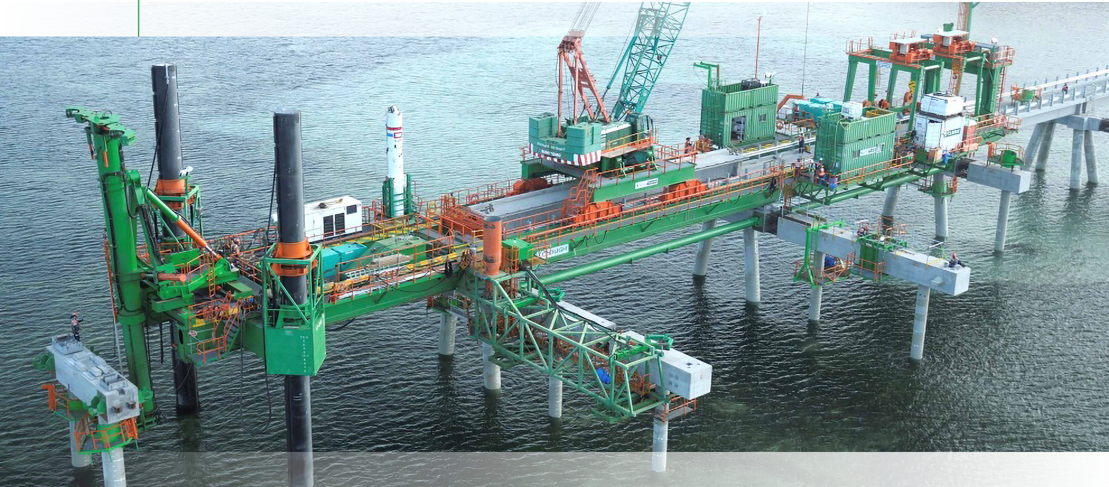
LNG-steiger in Papua New Guinea, gebouwd door BAM e.a.
