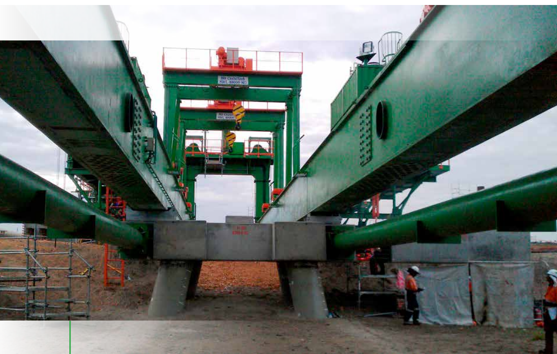
De onderbouwconstructie van een LNG-steiger in Port Moresby, Papua New Guinea
