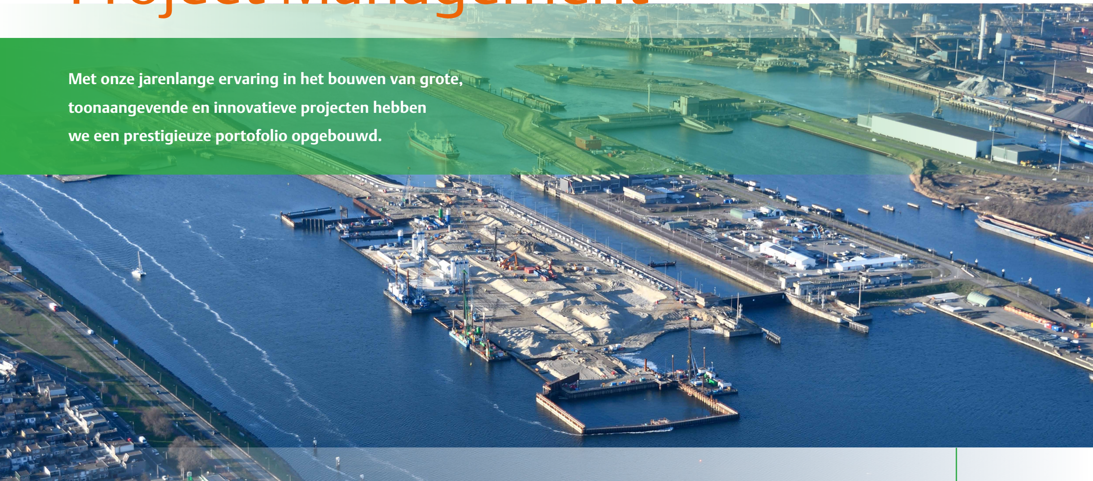
Zeesluis IJmuiden in aanbouw
